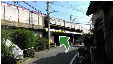
③ 通過 JR 的高架橋
