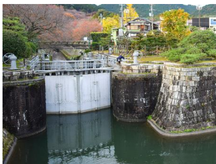
大津開門（電動化改修工事前）
